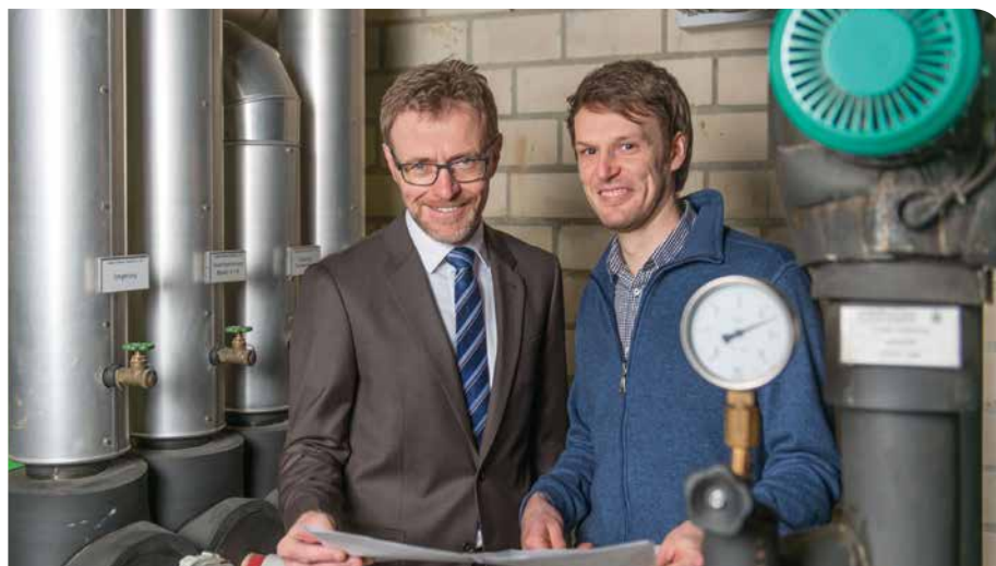
Auf der Suche nach Energiefressern: Detlef Bolte, Energiebeauftragter der Sparkasse Bremen, und Stephan Dederer, technischer Mitarbeiter der bregau GmbH (v.l.).
